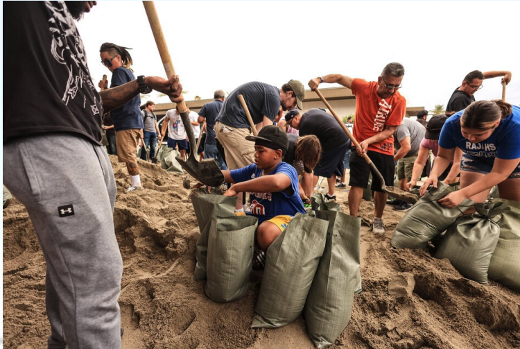
Barreras con bolsas de arena para evitar las inundaciones
